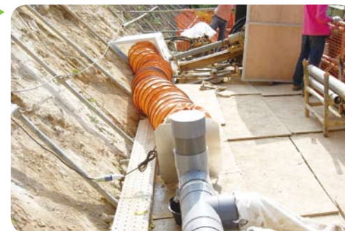
▲ 經改良的抽風系統分隔設備 ▶
