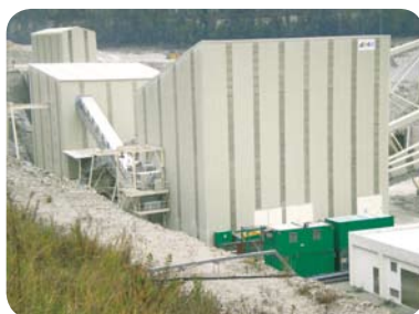
堅固密封無人的防塵埃壓石機廠房
