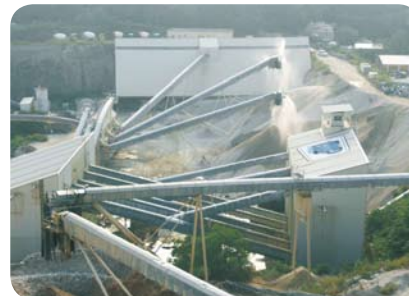
封閉式廠房及運輸帶設備
