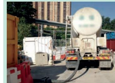
採用英泥車運送英泥漿到工地
